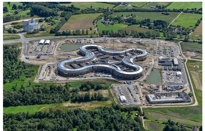
Byggeplads for Nyt Hospital Nordsjælland, juli 2023.
